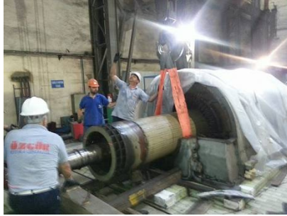
Rotor çıkartma
