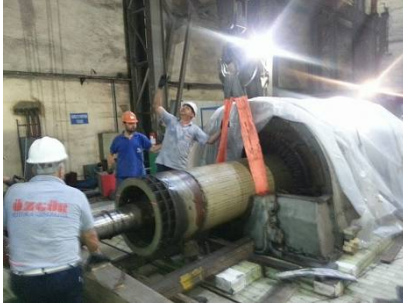
Rotor çıkartma
