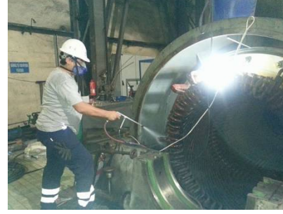
Rotor çıkartma
