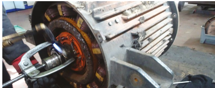
128 kW DC traction motor stator sarımı işimiz.
