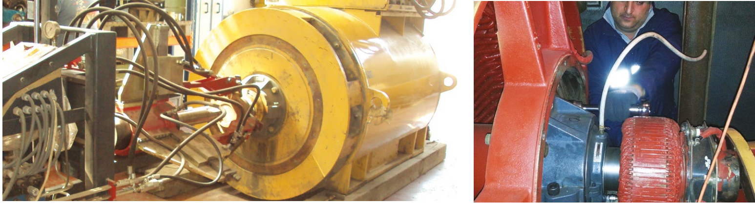
2500 KVA Kojenerasyon generatör atelye bakım ve yeni mil imali ve saha devreye alma işimiz. (KAZAKİSTAN)
