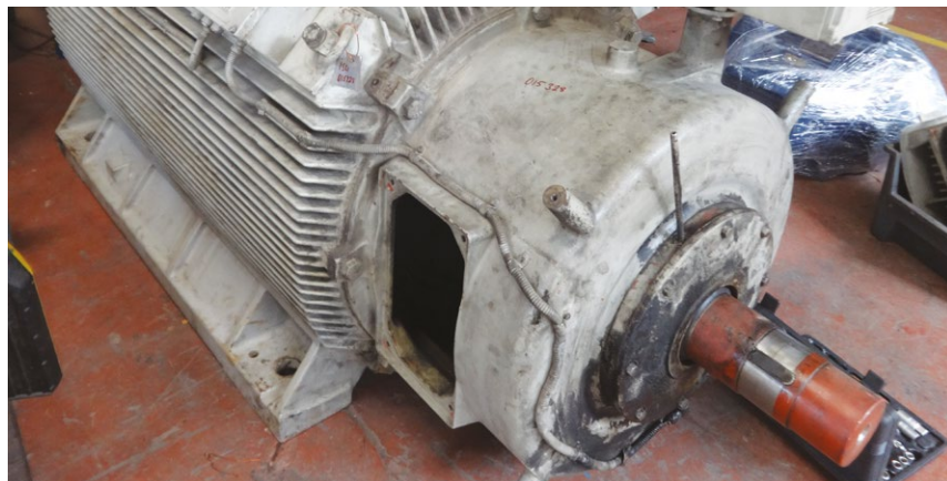
İSKİ 1000 kW Pompa motoru bakım ve onarımı.
